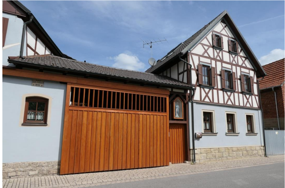
Hoftoranlage mit Fenstereinteilung, Erhalt der Fensterumrahmungen
