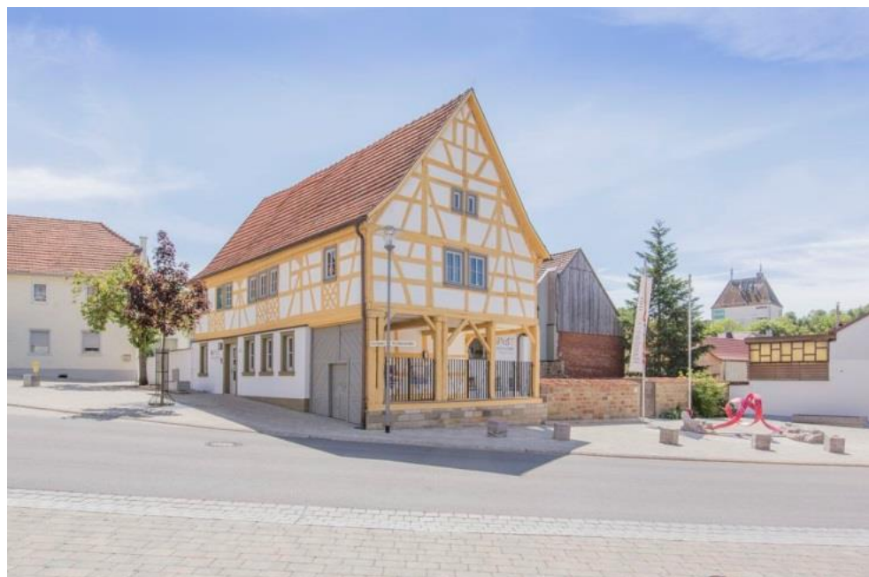
Überdachter Zugang am Handwerkerhof
