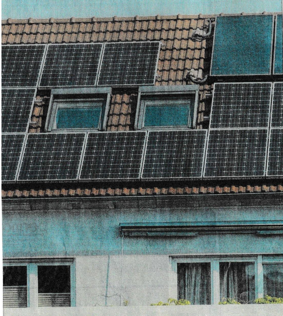
Beispiel für eine zu dichte u. verstreute Belegung mit Modulen
